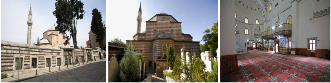
Şekil 4.53 Türbesi ve iç mekânı ile Vefa Camii genel görünümü (Fatih Belediyesi, 2017)
