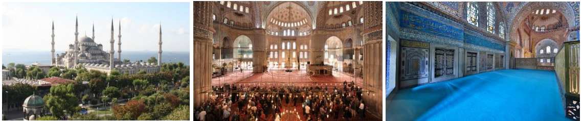
Şekil 4.52 Sultanahmet Camii, genel ve iç mekân görünümü ile hünkar mahfili duvarlarında bulunan çini örnekleri (Şahin, 2019)
