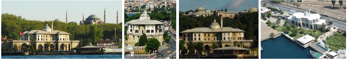
Şekil 4.73 Sepetçiler Kasrı genel görünümü (Cambaz, 2010b)
