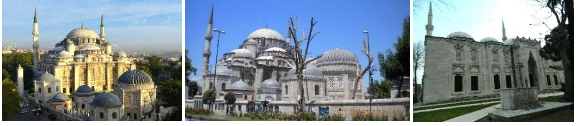
Şekil 4.49 Şehzade Mehmet Camii ve Külliyesi genel görünümü ve taç kapısı (Sezer ve Özyalçiner, 2010)
