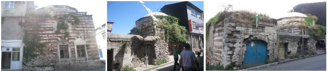
Şekil 4.51 Haydar Külliyesi genel görünümü (Fatih Belediyesi, 2019a)
