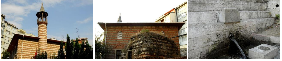
Şekil 4.58 Bıçakçı Alaaddin Camii minaresi, avlusundaki tatlı su kaynağı ve genel görünümü (Cambaz, 2010a)
