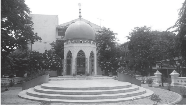
Resim 30: Şeyh Ahmad Türbesi'nin son onarım sırasında durumu (Roisri, 2021)
