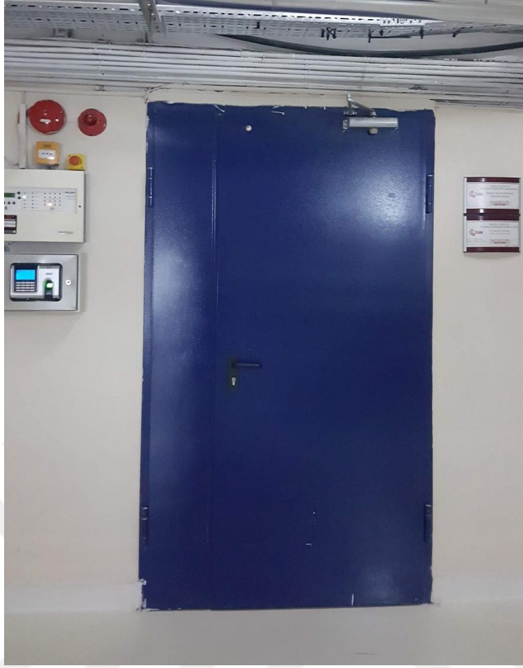
Resim 58: Sunucuların Bulunduğu Odanın Kapısı ve Güvenlik Sistemi
