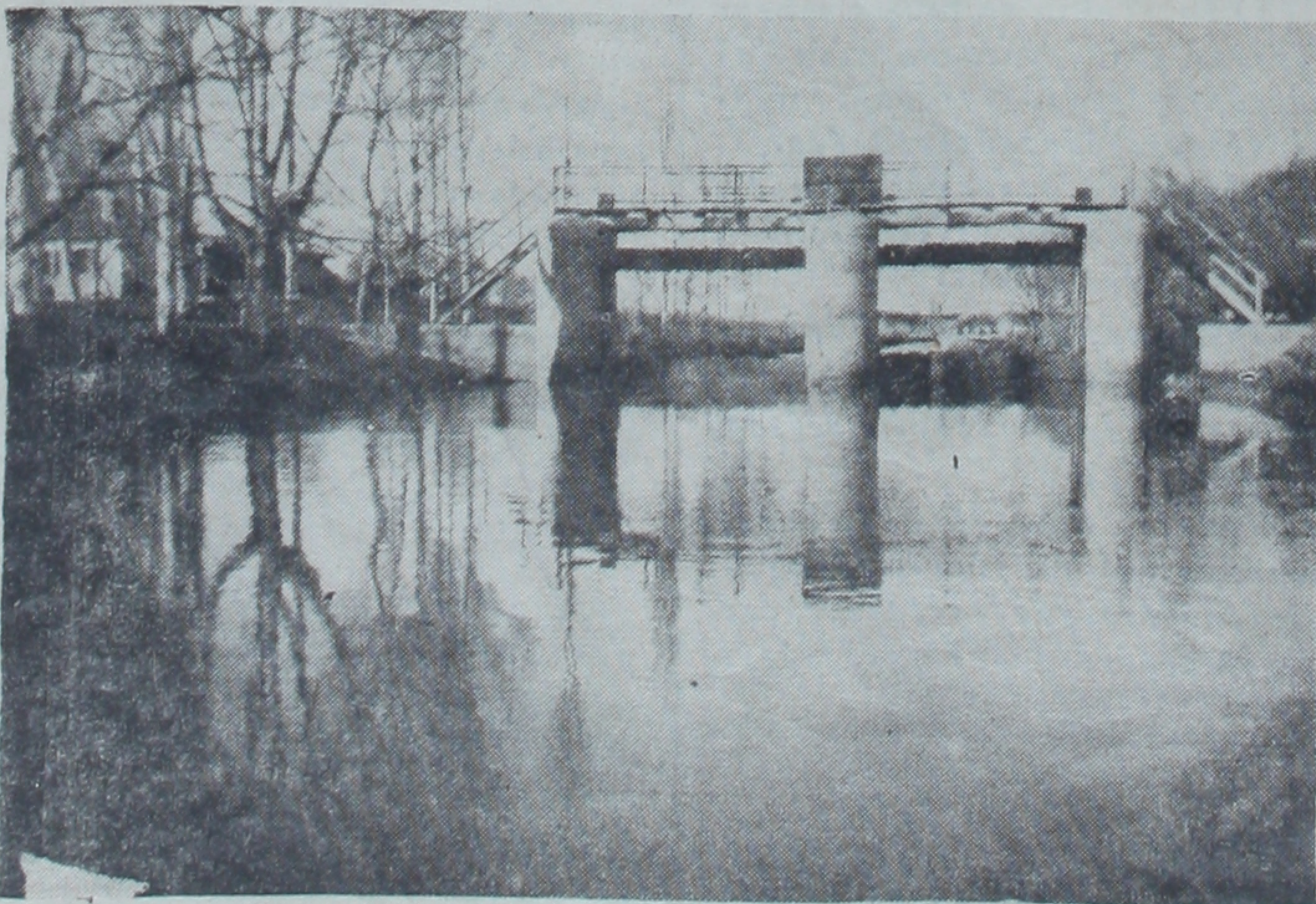
Alemdar barajının görünüşü
