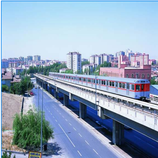
Şekil 7.12 Viyadük metro hattı
