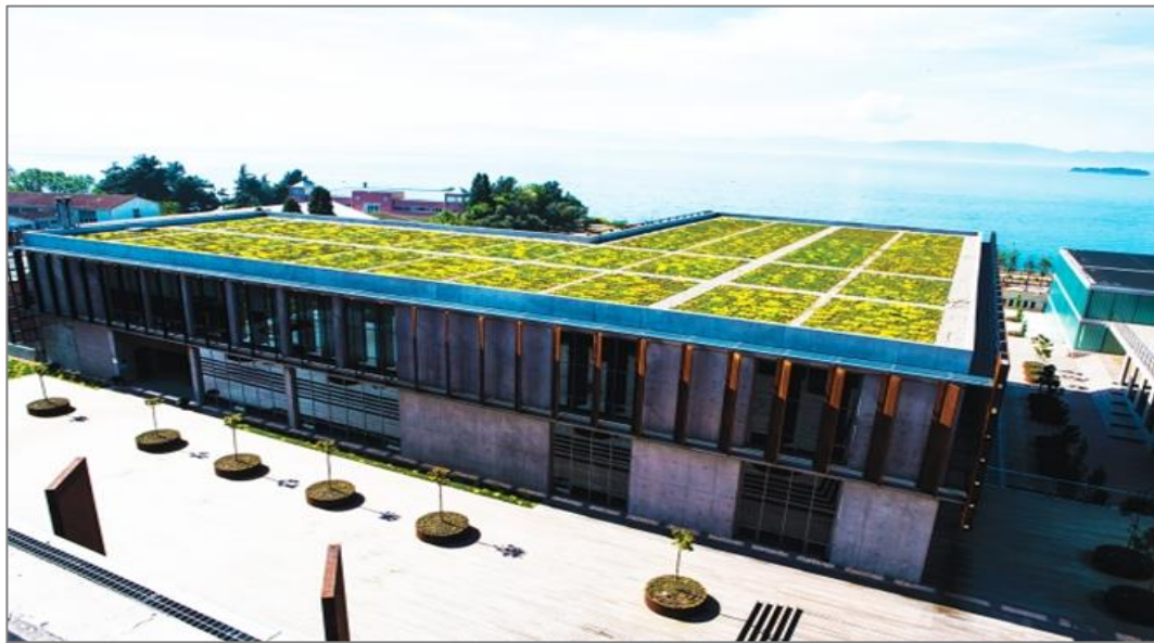
Şekil 4.14 Sedum cinsi bitki ile örtülü çatı
