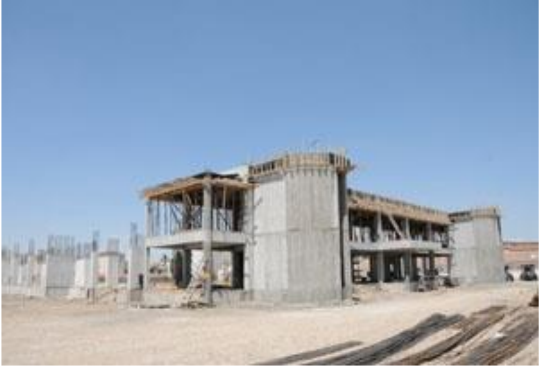
Şekil 3.1 Arsa tahsis örneği kapalı spor salonu inşaatı
