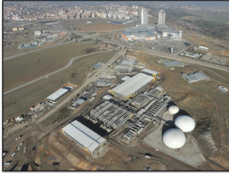
Şekil 4.1 ITC – Mamak tesisi
