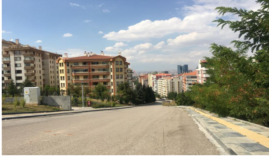
Şekil 4.24 1459. Cadde (Güney kısmı %15 eğimli yol)
