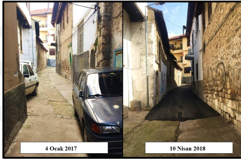
Şekil 4.50 Gazipaşa Caddesi kısmi asfalt çalışması uygulaması (Orijinal 2017-2018)
