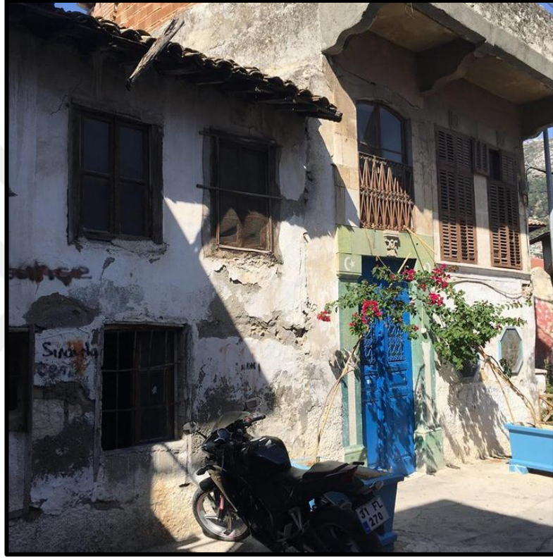
Şekil 4.43 Gazipaşa Caddesi üzerinde bulunan kullanılmayan yapı (Orijinal 2018)
