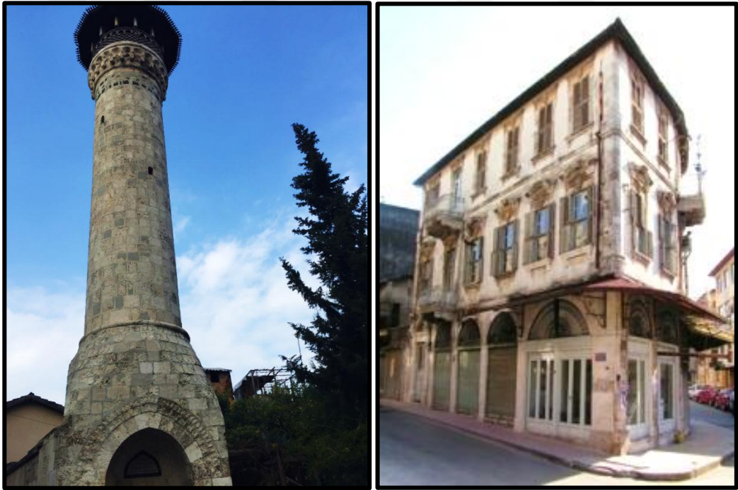
Şekil 4.31 Gazipaşa Caddesi'nin başlangıcında bulunan Kuseyri Binası (sağda) (Anonim 2018t) Gazipaşa Caddesi'nin sonunda bulunan Sarımiye Camii (solda) (Orijinal 2018)
