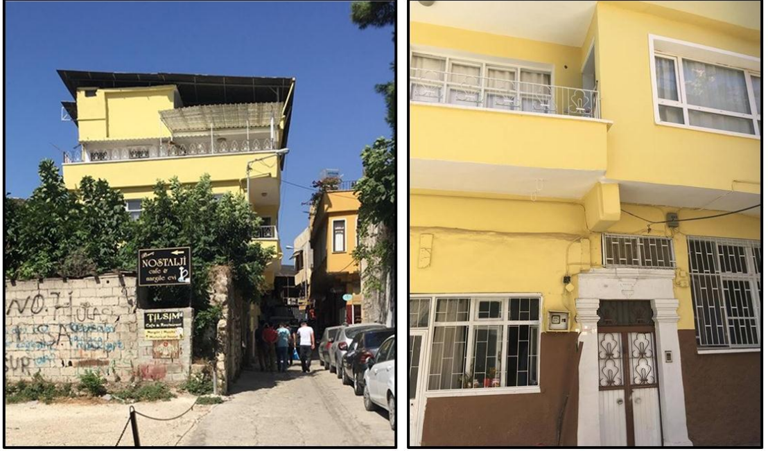
Şekil 4.39 Gazipaşa Caddesi üzerinde bulunan yeni yapı örneęi-1 (Orijinal 2018)
