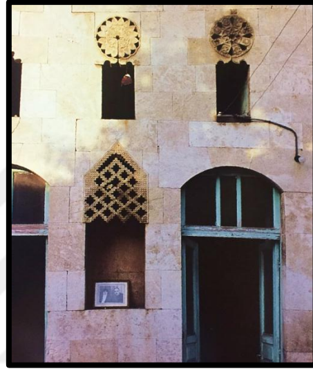
Şekil 4.24 Avlu cephesinde bulunan farklı motifli kuş takaları (Demir 1996)
