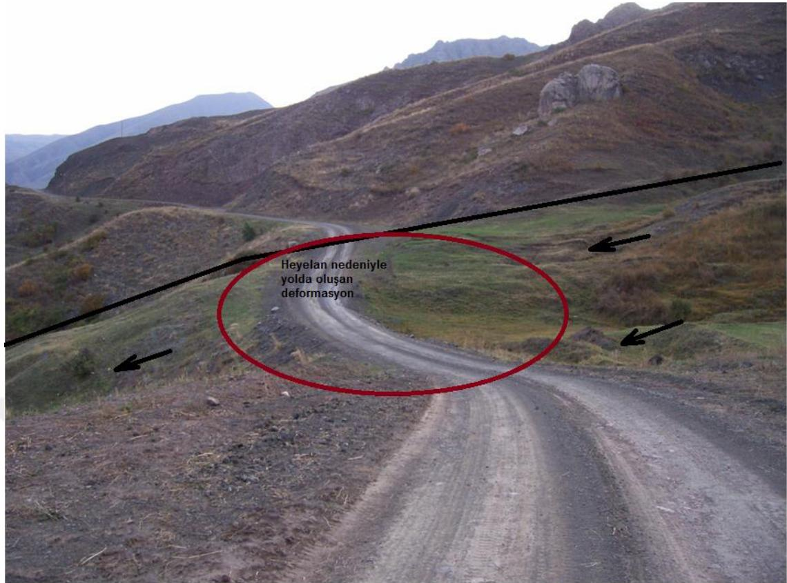
Şekil 5.63 H.4 heyelanının yolda oluşturduğu deformasyon (kuzeyden güneye bakış)
