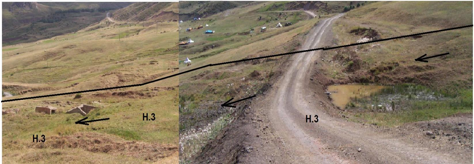
Şekil 5.43 H.3 No.'lu heyelan ile kayan menfezin ve oluşan göllenmenin yol üzerinden görünümü (kuzey doğudan güneybatıya bakış)
