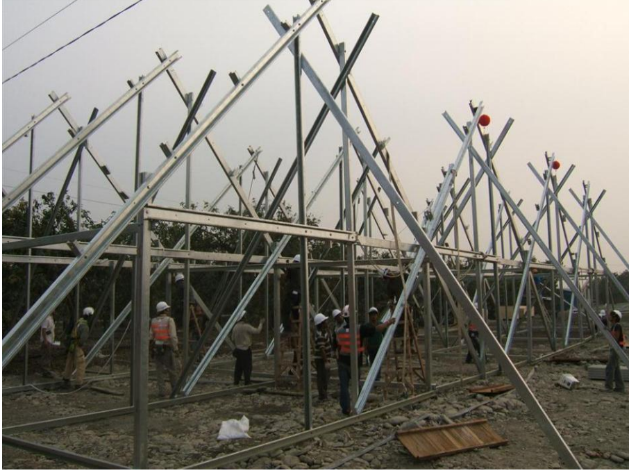
Şekil 6: Fu-shan Köyü'nde yeniden yapılanma sırasında kullanılan basitleştirilmiş civata somun bağlantılı çelik çerçeve. Dawu, Taitung, Tayvan, 2010. Kaynak: Atelier-3.
