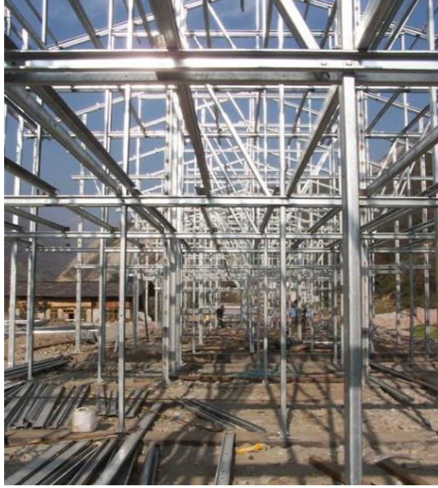
Şekil 2: HSIEH ve ekibinin afet sonrası yeniden inşaat çalışmalarında hafif çelik çerçeve uygulanmıştır. Kaynak: Atelier-3.
