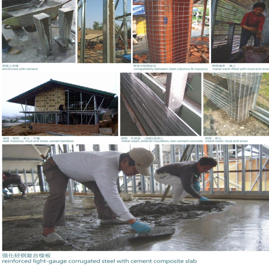
Şekil 8: HSIEH ve ekibi, yenilikçi inşaat yöntemlerini, metal örgülü ince beton membranlı zeminini oluşturmak ve sıkıştırılmış toprak ve saman balyalarının metal örgüyle güçlendirilmesiyle oluşturulan duvarın inşası için sağlayabilirler. Kaynak: Atelier-3.
