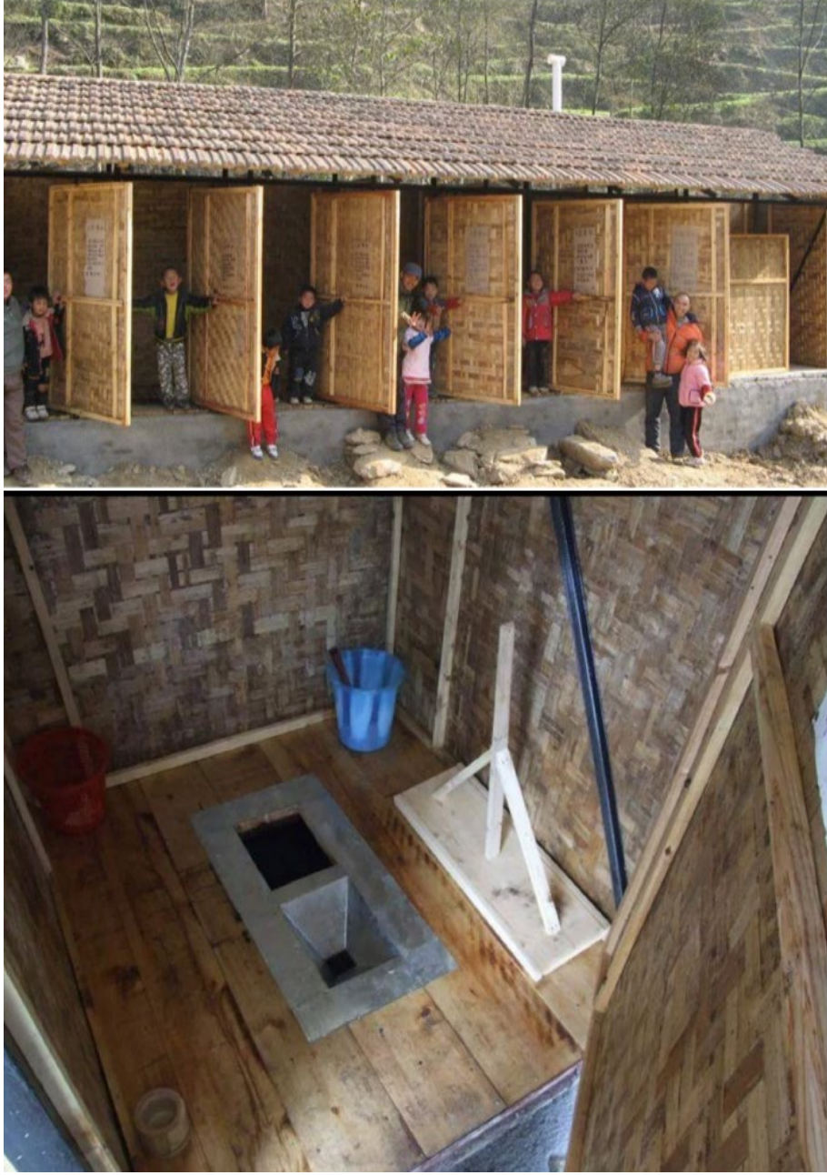
Şekil 9: Mianzhu'da uygulanmış kuru tuvalet sistemi. Guangyuan, Sichuan, 2008. Kaynak: Atelier-3.
