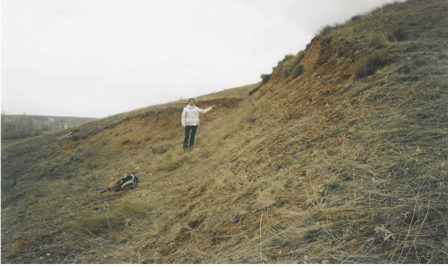
Şekil 6.5 İkincil heyelanın ayna kısmı (Batıdan Doğuya bakış)
